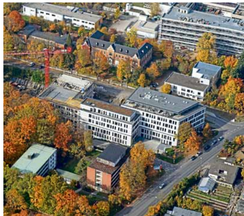
Luftaufnahme des Neubau-Projekts „Gesundheitspark Schweinfurt“ in zwei Bauabschnitten.
