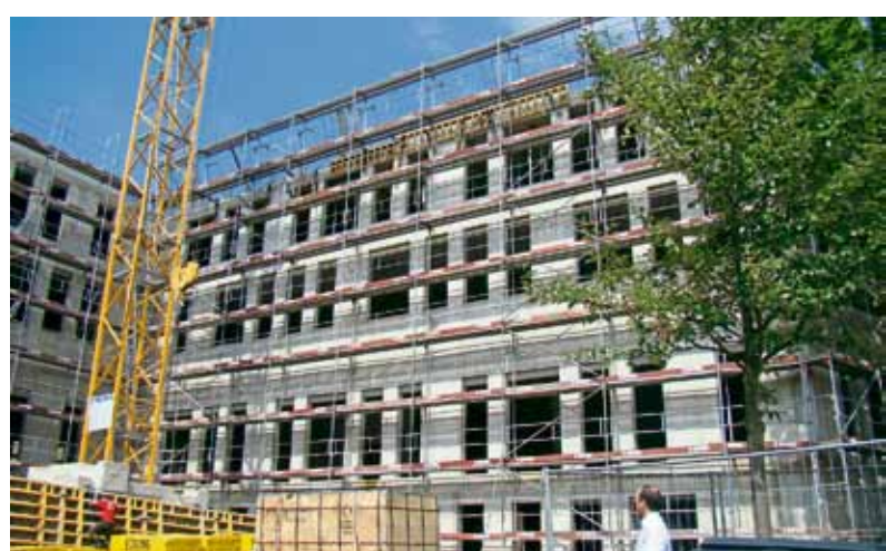
Neubau des medizinischen Versorgungszentrums „Gesundheitspark Schweinfurt“.
