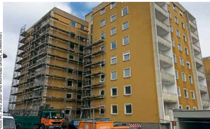
Beginn der energetischen Fassadensanierung der Wohnanlage Hermann-Barthel-Str. 62.
