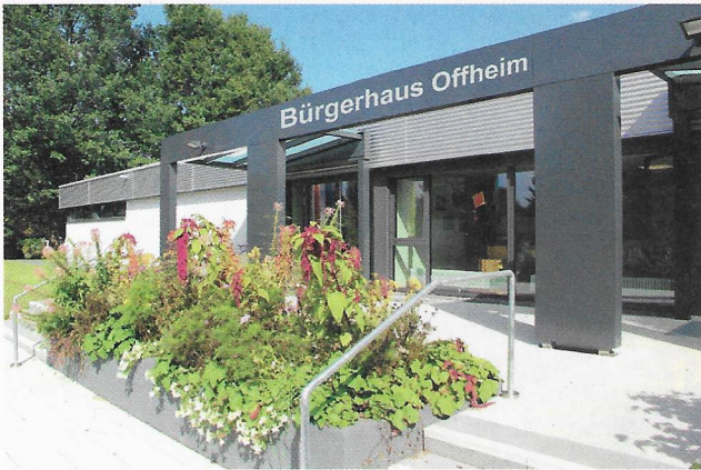
Haupteingang des Bürgerhauses Offheim
