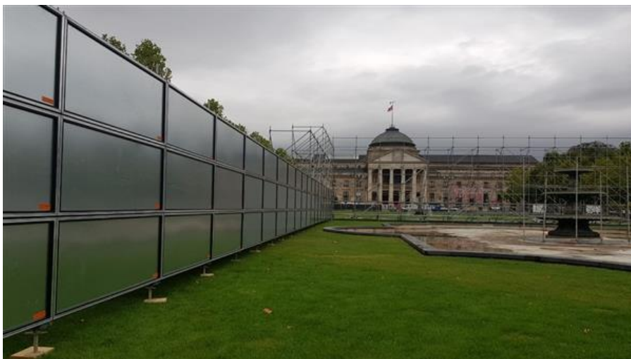
Abbildung 2: Foto von Gerüst Schießstand in Wiesbaden
